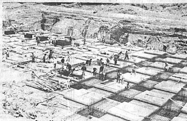
Ampliación del servicio de aguas potables
