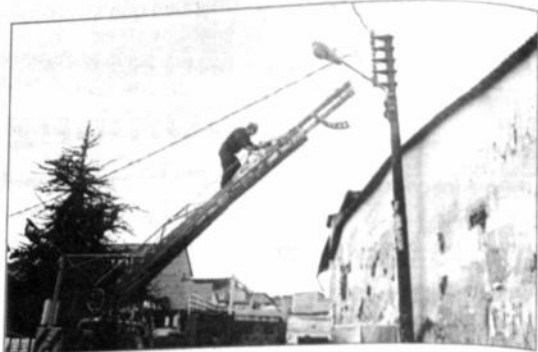
Obren a COBEE, proceso al corte de energía eléctrica.
