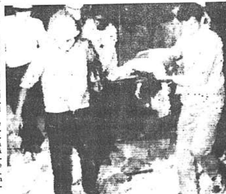
DERRUMBE EN UNA IGLESIA. Cuadrillas de salvamento sacan al día de los 19 cadáveres en la iglesia de San Mateo Consagrada donde se derrumbó el techo de una nave. (Guadalajara, México, Nov. 30 RADIOFOTO AP)
