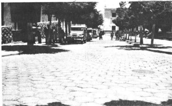
Plaza "10 de Noviembre" presenta una vista nueva y moderna con el trabajo de enlosetado. La fotografía muestra la parte que da al edificio de la Alcaldía Municipal.
