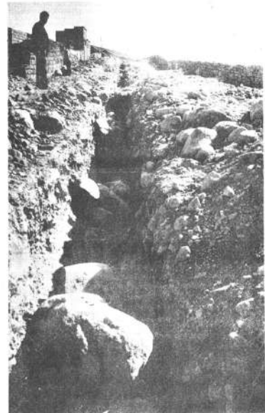
La Junta, dentro del plan anual, realizó también trabajos de alcantarillado en la calle San Alberto, dando ocupación a numerosos obreros.
