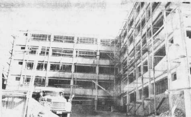
La Universidad "Tomas Frías", está acelerando la construcción del edificio de 5 pisos destinado al internado universitario. Cobijará en su interior a 350 alumnos. (Foto CIMA)
