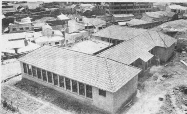
Vista parcial de los gabinetes de física y metalúrgicos de la Facultad de Ingeniería. Al fondo el internado universitario todavía en construcción, con esta entrega se formará un núcleo universitario sobre las avenidas Maestro y Serruto. (Foto CIMA)
