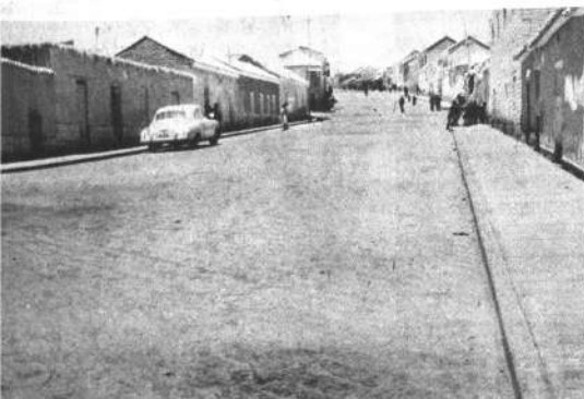
La ancha avenida Chayanta ha cobrado una nueva y distinta fisonomía con el adequinamiento que efectuó la Junta de OO.PP.
