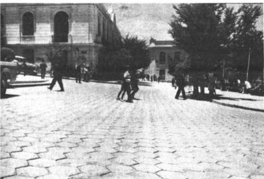
Esta es una vista del aspecto que presenta la Plaza Principal de la Villa Imperial, después de haber sido utilizado el sistema de enlosetado, obra efectuada por la Junta de OO.PP.
