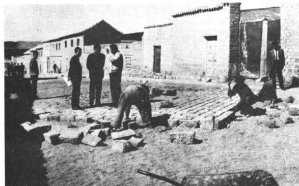
La calidad de los adoquines empleados en la modernización de la Av. Chayanta, ha sido debidamente seleccionada. El trabajo, dió ocupación a cientos de trabajadores.
