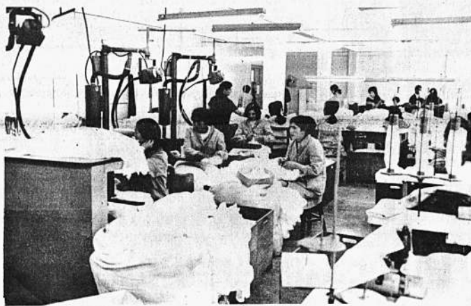
La sección procesada de las medias pasa el producto al control de fallas, donde las medias que tienen defectos de fabricación son seleccionadas para su inutilización.
