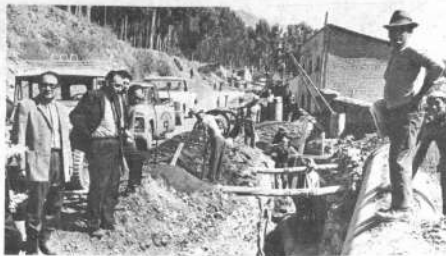
El Alcalde Municipal, Gral. Hugo Suárez Guzmán, y técnicos de la Comuna y SAMAPA, inspeccionaron ayer los trabajos de ampliación del servicio de agua potable de la ciudad de La Paz, que se encuentran bastante avanzados.
