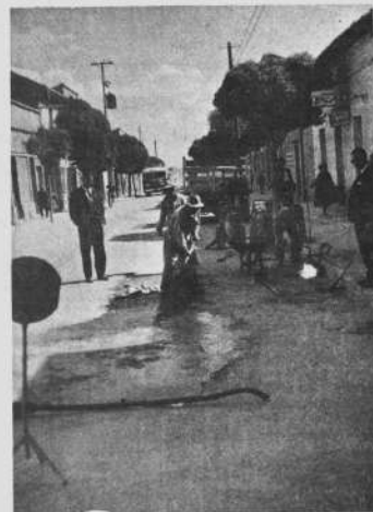
-Una de las preocupaciones del actual Jefe Comunal es el arreglo de las calles de la ciudad que fueron destruidas por SELA. Actualmente se cumplen trabajos de resellado en diferentes sectores de la ciudad.
