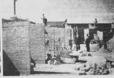
-Fébrilmente se trabaja en el Mercado Caqueo de la Zona Norte donde se efectúan ampliaciones para dar mayor comodidad a los comerciantes y amas de casa de ese sector.
