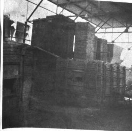
Uno de los hornos donde se reduce a metálico el óxido de antimonio.
