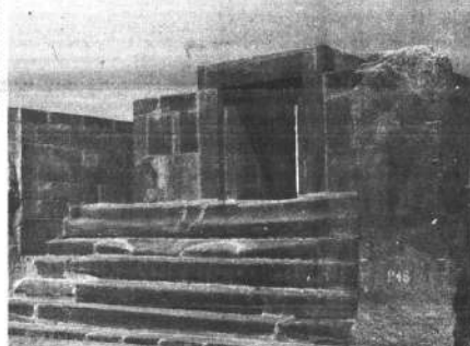
La misma escalinata después de ser reconstruida por el CIAT.
