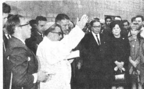
Monseñor Jorge Manrique bendijo ayer las instalaciones de los primeros bloques de la Ciudad Universitaria en ceremonia que al canzó realce, por la trascendencia de la obra.
