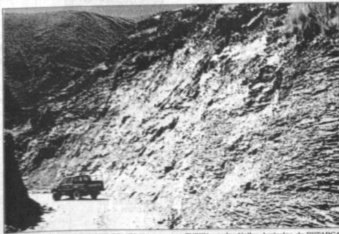
CAMINO CARRETERO RIFIADO DE 120 Km. que une TUPIZA con los Valles Agrícolas de ESTARCA, CHACOPAMPA, PALQUIZA, QUEBRADA SECA, MINA CANDELARIA, SAN VICENTE con conexión del GRUPO DE "COMIBOL" y tramo Ferroviario de ATOCHA, con alcantarilla zanjas de coronación y obras de arte.
