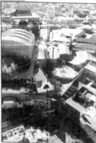
Para la construcción del Túnel del Instituto Americano el Concejo ya aprobó su presupuesto. Sólo falta iniciar obras.
