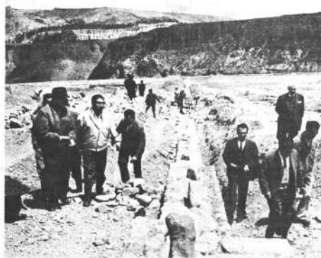
El Alcalde Suárez Guzmán y técnicos municipales, durante la inspección de obras en Achumani, donde se trabajarán terrenos para el encauzamiento del río Achumani, donde se trabajarán terrenos para la nueva urbanización de empleados municipales en esa región.
