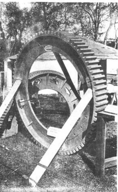
Una pieza de molino de minerales, fabricada en una de las maestranzas de Comibol. Su peso es de 1,800 kilogramos. Miles de personas tuvieron la oportunidad, por primera vez, de apreciar el equipo pesado de la minería.
