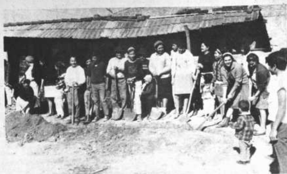
Vecinos de diferente edad y condición social de Pary-Oeste, bajo el lema de común esfuerzo, terminaron exitosamente los trabajos de instalación de la red de agua potable. Varios barrios de esta ciudad aún carecen de los servicios públicos más elementales.
