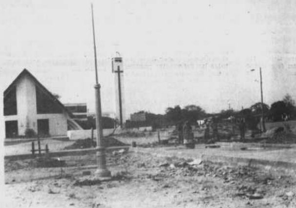
Plaza de El Pary, donde se ejecutan trabajos de remodelación. La arborización también está contemplada, y estará a cargo del Departamento de Parques y Jardines.
