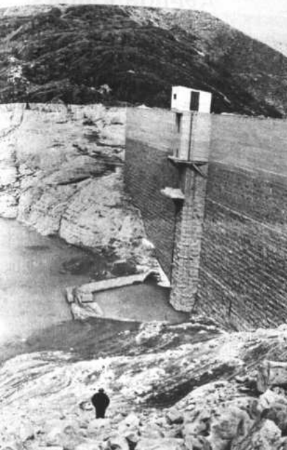
El muro de cierre del lago de Zongo aparece seco. Normalmente, el agua llega hasta el borde superior de donde, a veces, rebalsa sobre la quebrada de Zongo. Ayer, el Alcalde verificó que el nivel del agua ha descendido a los 112,5 cms, siendo el promedio de descenso de dos centímetros y medio por hora. Se justificó el racionamiento, pero el Gral. Escobar acusó de improvisación a Bolivian Power.
