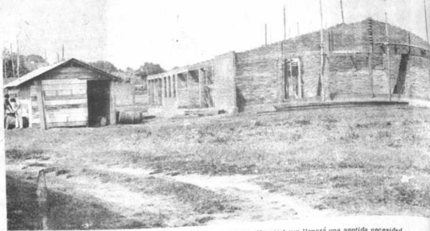
Una obra muy significativa para Cobija, el futuro Hospital que llenará una sentida necesidad
