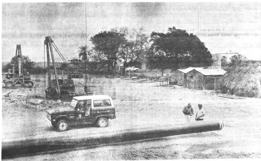
A pocos metros de la boca del pozo donde arde el gas en el campamento de Colpa, empieza el gasoducto en actual construcción. En la fotografía parte de la tubería inicial.
