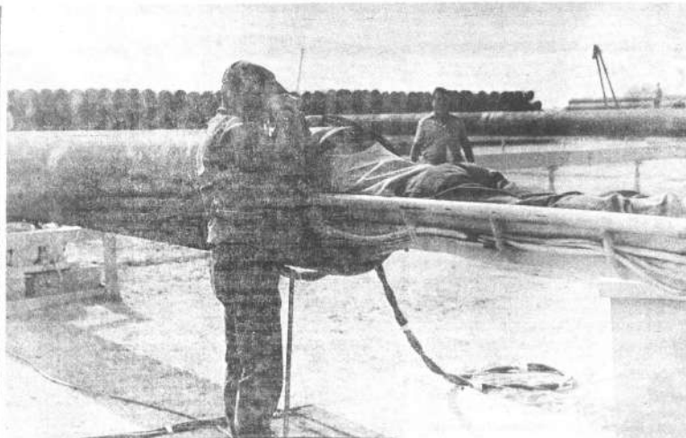
Para soldar los tubos es necesario un procedimiento especial que garantice el trabajo perfecto. Los tubos reciben capas de soldadura exteriormente e interior, para la última labor, un soldador especializado (en la fotografía), es introducido mecánicamente dentro del tubo para efectuar el trabajo.
