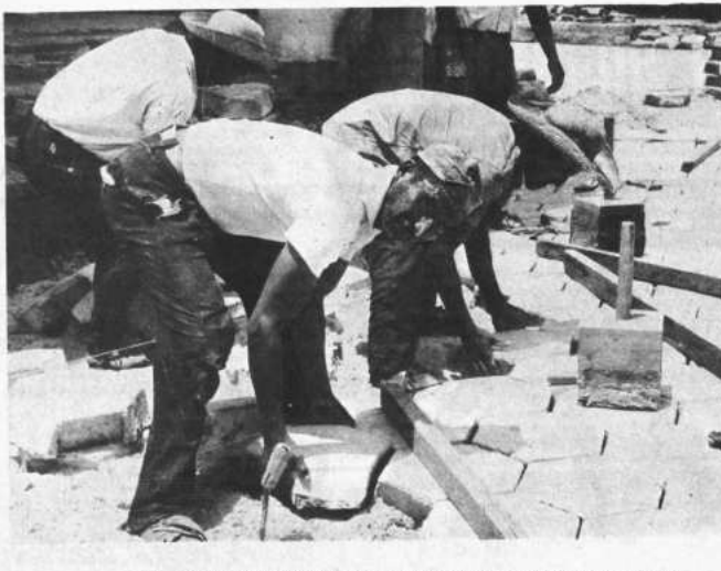
Se han invertido millones de dólares en la pavimentación de calles en la progresista ciudad de Santa Cruz. Trabajando con varias organizaciones financieras dentro los principios de la Alianza para el Progreso, esta ciudad progresa por medio de su propio esfuerzo.
