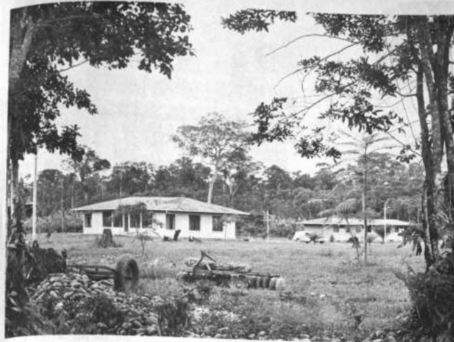
Una parte de las modernas y sólidas construcciones de la estación experimental de Chipiriri construidas con asistencia financiera de USAID, dentro del programa de la Alianza para el Progreso.
