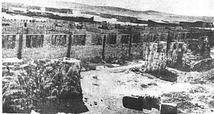
Villazón con el esfuerzo propio de sus pobladores está construyendo un Hospital. El comité respectivo reclama al Gobierno se le haga justicia para la devolución de fondos departales de la Comuna tarijeña. Muchas madres bolivianas dan a luz en el Hospital de la Quilaca, Argentina, por la falta de atención sanitaria en Villazón.
