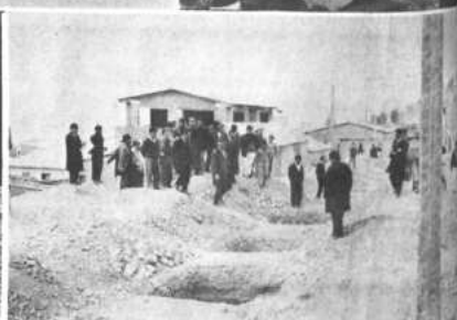
ALCANTARILLADO. —El alcantarillado en las zonas marginales de la ciudad es atendido preferentemente. ▲
