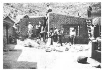
Pobladores de Llavica de la provincia Nor Lípez trabajan en la construcción de un puesto sanitario.
