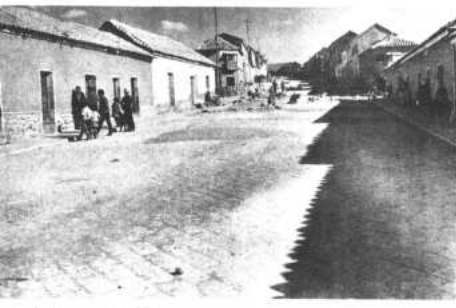
La Junta de OO.PP. en su programa de adoquinamiento de calles, actualmente trabaja en la larga calle "Chayanta", desde la esquina del cementerio, que comprende más de 4 cuadras.
