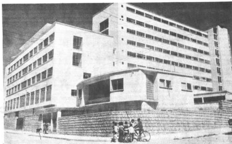
Una vista del anexo del edificio del Hospital Obrero construido con recursos propios de la CNSS.
