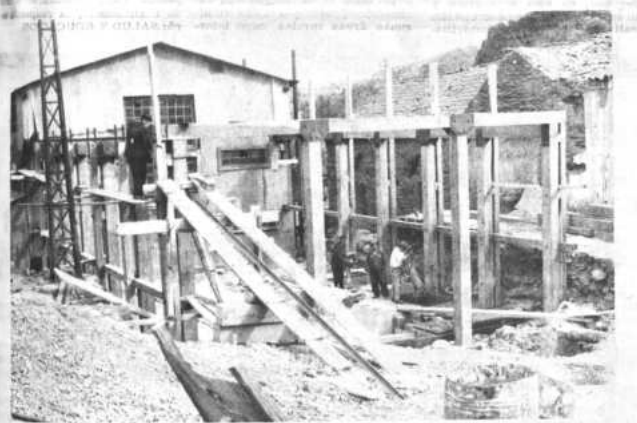
Con lentitud se construye el galpón "Volador" para el funcionamiento de dos grupos electrógenos que aumentarán el servicio de energía eléctrica en Potosí.
