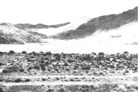
El mantenimiento de la provisión de agua a la población, es constante preocupación de la Junta. El muro que aparece en color blanco en primer plano, ha sido reparado e impermeabilizado en su integridad, en la Laguna Chalviri.
