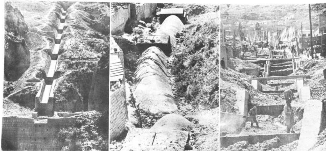
CANALIZACION. —Obras de canalización, riachuelos (Vino Tinto, Olimpic (San Pedro) y calle Beni (alturas del río). ▲
