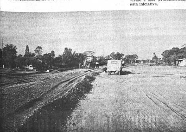
Este es el segundo anillo de circunvalación, que en días más, será entregado totalmente asfaltado. Favorecerá al margen de la modernización, al descongestionamiento del tráfico. Numerosas poblaciones rurales también se benefician con trabajos de captación de agua potable y electrificación. (Foto NIKKA).
