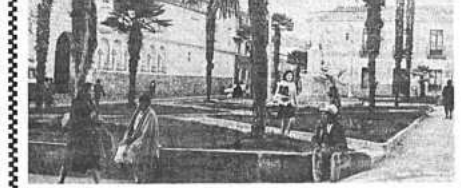
OBRA COMUNAL Remodelación de la plaza "Frías"
