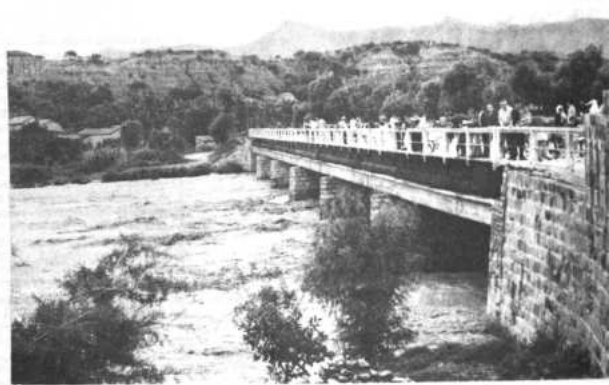
El caudaloso río "Guadalquivir" y el puente San Martín.
