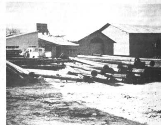
Local de Obras Públicas Municipales, donde se construirá un Supermercado moderno de 3 pisos con toda clase de comodidades.
