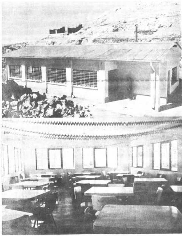
Fachada y comedor principal del Club Social Obrero de San José ➡
