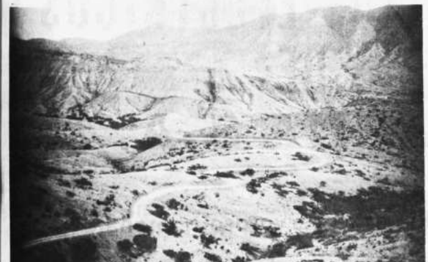
Con ayuda del Servicio de Caminos, las carreteras tarijeñas han podido conservarse en buen estado.
