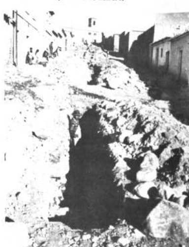
En muchas arterias alejadas del centro de la ciudad se están haciendo trabajos de alcantarillado, como el de la foto en la calle Páez, Pando.
