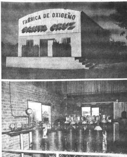
Ariba.- Este es el edificio de la Fábrica de Oxígeno es una de las últimas industrias que ha abierto sus puertas. Conjuntamente con la planta de Liquid Carbonic, están cubriendo la demanda interna de oxígeno industrial y medicinal. Abajo.- Una capacidad máxima de 136 botellones de 6 mts. cúbicos, con 2,000 libras de presión que tienen ambas plantas. Trabajan en edificios contiguos y el tiempo que tienen operando en la ciudad es de tres semanas. En el país existen un total de cinco plantas. (Foto Nirka).
