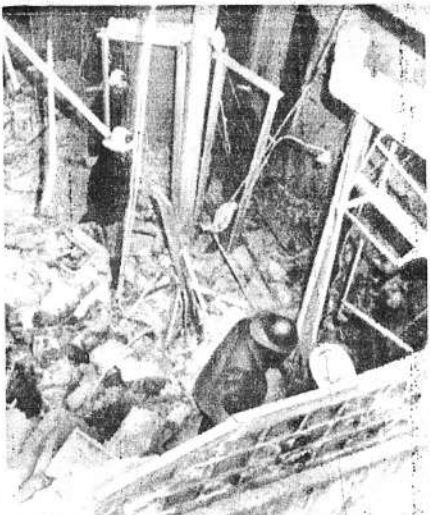
BUENOS AIRES, 1 (AP). - Los bomberos revisan los escombros de la sede de obreros metalúrgicos en esta ciudad después de estallar una bomba en el mismo ayer. Al mismo tiempo los obreros metieron a Augusto Varr. Se le había opuesto a una huelga general contra la visita de Rockefeller.
