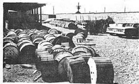
1.198 toneladas de material procedentes del Japón que fueron transportadas a Arica y La Paz por cuenta de TASA, luego almacenadas y distribuidas a las distintas construcciones e instalaciones.
