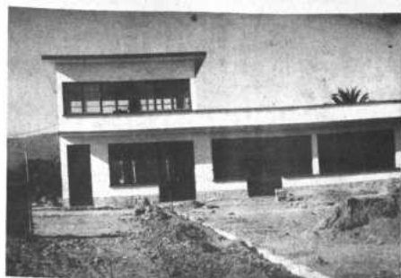
En Tarija, el edificio terminal del aeropuerto "Lea Plaza" está tomando una nueva fisonomía, como resultado de los trabajos que realiza la Administración de Aeropuertos. La obra está a cargo de la empresa Camponobo. (Foto PRESENCIA)
