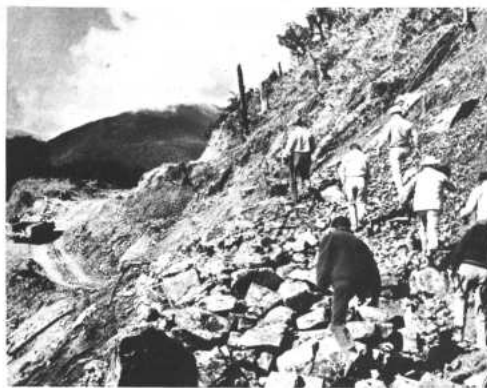
En la zona de Piracti, entre Cochabamba y Villa Tunari, se debe construir un túnel, cuyo costo la TAMS cotizó en doscientos mil dólares, pero ahora subió de precio y costará 400 mil dólares. Aquí un muestra de la visita de observación que realizó al proyecto caminero Uno y Cuatro, el Ministro de Obras Públicas.
