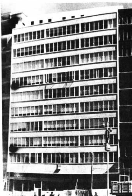
Este es el nuevo edificio de Teléfonos Automáticos de La Paz, de nueve pisos, que servirá para albergar las secciones administrativas y técnicas de la empresa telefónica. Ayer debió haber sido entregado a TASA, de acuerdo a contrato, pero la empresa constructora falló y recién en los próximos días podrá conectar alcantarillados y disponer de agua potable. La cortina metálica en la puerta principal aún no ha sido colocada y faltan algunos detalles de acabado.
