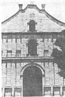
VIACHA.- Fachada de la Iglesia. (Foto Mesa).
