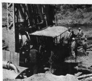
Santa Cruz, 23 (PRESENCIA).- Se ha iniciado la construcción de dos importantes puentes del tramo
