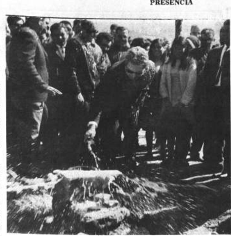
Monseñor Alfred Kleinermerliert, Obispo Auxiliar de Tréveris, rompe una botella de champá sobre la piedra fundamental que colocó en los terrenos donde se construirá la Escuela Profesional de Artes y Oficios en Patacamaya. Lo rodean el Obispo de Coroico, Mons. López Lamas y los señores de esa localidad.
