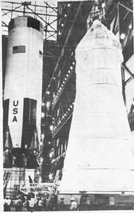
La primera sección del cohete Saturno-V, al fondo, aparece cuando era trasladado a su sitio respectivo del edificio de ensamblaje, antes de colocarlo en la plataforma móvil. En primer plano se ven, ya unidos, los módulos de Comando, de Servicio y Lunar.
