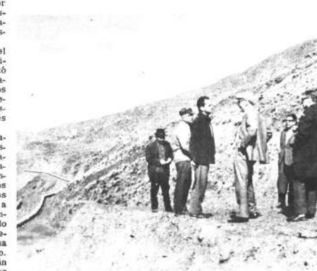
El Ministro Erhard Eppler, de Alemania, luciendo una gorra blanca, admira el paisaje paceño desde una de las cumbres de Hampaturi, a donde fue ayer de visita con el Alcalde Escobar Urra para inspeccionar las obras de reconstrucción del sistema de captación que se realizan con el crédito alemán de 15 millones de marcos.
