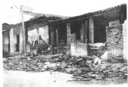
Numerosas viviendas se derrumbaron en esta ciudad, la antenna de 54 metros de altura de "Radio Grigotá" fue derribada por un rayo. En la región de San Aurelio (zona Sur) más de 14 postes telefónicos fueron volteados, en igual forma en La Héglica, una granja criadora de aves en la ruta a Montero se desplomó matando centenares de pollos, numerosos árboles han sido derribados por el fuerte viento. (FOTO NIKKA).
