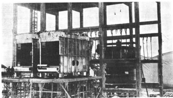
Electrofiltros y edificio de tostación. La estructura metálica ya está casi totalmente levantada.
