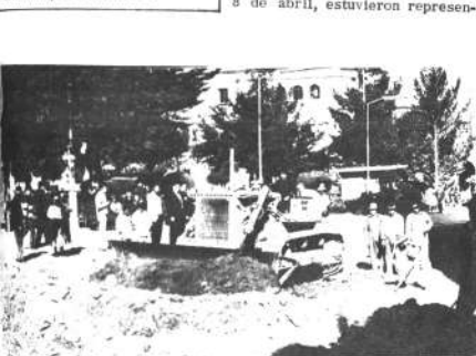
En la ciudad de Potosí, la Junta de Obras Públicas comenzó con el ensayado de la plaza principal reemplazando el pavimento que se encontraba en mal estado de conservación. El tipo de losetas es similar al utilizado en la ciudad de Santa Cruz. (Foto CIMA).
