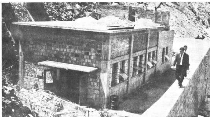
Casa de máquinas de la planta hidroeléctrica.
