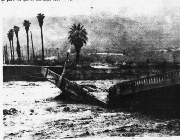
LOS ANGELES, 26 de febrero.- Las torrenciales lluvias desplomaron este puente en la sección de Tujunga en Los Angeles, al comenzar a descender las aguas del Tujunga - que lo convirtieron en alud líquido, ayer. (RADIOFOTO AP)
