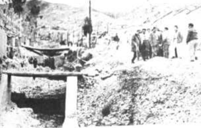
Canalización de un riachuelo en uno de los sectores poblados de la población, que impone mantenimiento permanente.
