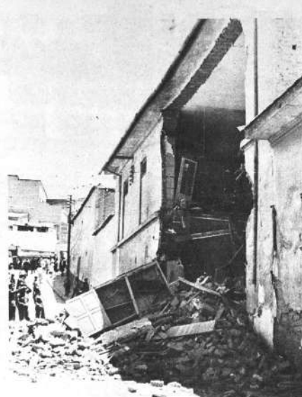
Aquí quedó la casona del Hospicio de San José al desplomarse parte de su frente sobre la calle Almirante Grau, exactamente frente al sitio donde hace tres años fueron aplastados dos niños de las Sagradas Comarcas por un ómnibus. Cuadrillas municipales, posteriormente, demolieron el edificio para prevenir la amenaza de nuevos desastres.
