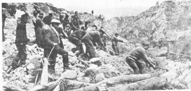
Sin embargo, no todo es desolado o desidia. Vemos al Alcalde, con su ya típico traje de trabajo, ayudando a obreros municipales en la remoción de escombros y retiro de árboles caídos en una zona de deslizamiento. Da ejemplo personal de trabajo a sus ingenieros, algunos de los cuales miran el trabajo del jefe de la Comuna pacense.
