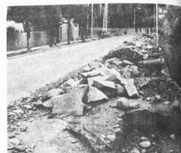
Esta fotografía no necesita comentario. Su simple mirada re el abandono en que se encuentran muchas obras. Así estaba el camino a Obrajes días antes de producirse el deslizamiento de uno de sus sectores.
