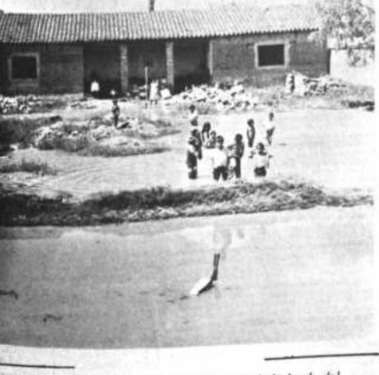
Así quedó una de las casas afectadas por el desborde del canal de riego de la Angostura, como consecuencia de la fuerte precipitación pluvial caída en la zona de Jahuayco.
