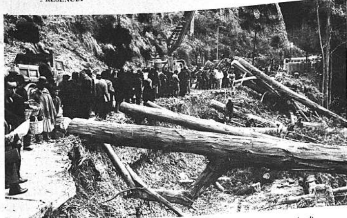
La Avenida del Libertador, camino a Obrajes, sufrió nuevas interrupciones y se ha dificultado el paso de peatones. La Municipalidad estudia averiguar la adjudicación de los trabajos de reparación a una de las firmas constructoras locales. Entre tanto, se anticipó que dichos trabajos demorarán por lo menos cuatro meses.
