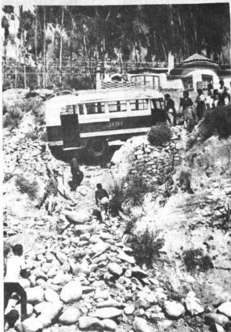
Este colectivo de la línea 5 quedó colgado con las ruedas traseñas en el aire, después de que el terreno por donde circulaba cediera a su paso. El lugar del accidente está situado en el camino de desvío a la altura del segundo puente de la ruta a Obayes. Hasta anoche el vehículo seguía en la misma posición "debido a que no se pudo encontrar al conductor del mismo, Vicente Yujra, para establecer las causas del mismo", según informó la Comisión de Tránsito.
