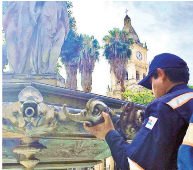
La reparación de la pieza afectada.
