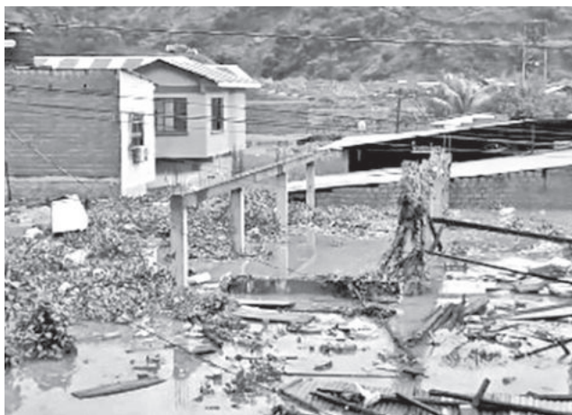
Viviendas afectadas por inundaciones. SOMOS TIPUANEÑOS
