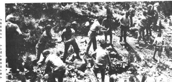
Los vecinos de Villa 18 de Mayo iniciaron el domingo los trabajos para ampliación y mejora de la toma de agua potable de su zona. Encabezados por los dirigentes de la Junta Vecinal de esa villa fabril, numerosos vecinos trabajaron con entusiasmo en una demostración de esfuerzo propio.
