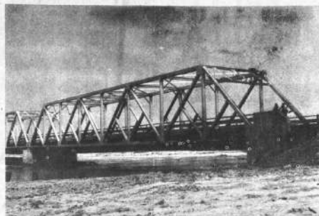
Una vista parcial del Puente Eisenhower, sobre el río Pirai, en el camino a Portachuelo. El Servicio Nacional de Caminos se encuentra construyendo defensivos para preservar esa obra metálica. (Foto NIKKA)
