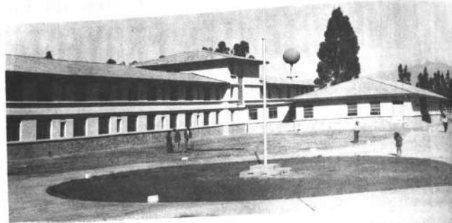
Con una inversión de un millón de dólares fue construido un moderno Hospital en Cochabamba. Se trata de una obra católica. Es el Hospital "Seton".
