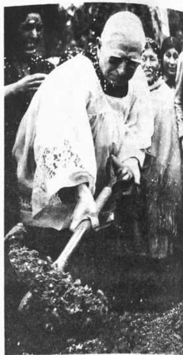
1963. En un barrio popular de esta ciudad, el Arzobispo de La Paz, es visto en labores de construcción de la piedra fundamental de una de las obras sociales que fueron emprendidas durante el biennio episcopal.
