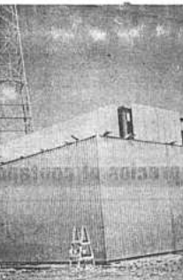
Las paredes externas del edificio cubiertas con planchas galvanizadas, dentro de las cuales va el material aislante, las planchas galvanizadas son sumamente resistentes a los agentes atmosféricos. Se señala que el recubrimiento del edificio estará concluido en la segunda quincena de este mes.
