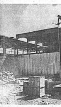
En esta parte del edificio ya se ha recubierto la parte inferior y se está colocando el techo. Una vez concluida la fase de recubrimiento, la Empresa PLASMAR iniciará la colocación de desagües y canalones. Posteriormente se instalarán los equipos, quedando todo listo a principios de marzo.
