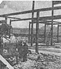
Los técnicos de Fabrimetal en plena labor, la empresa española envió a seis técnicos al mando de José Luis Martínez Ing. Jefe, ellos y más dos ayudantes bolivianos levantan toda la estructura metálica en menos de dos meses, tiempo realmente corto para una construcción de ese tipo.
