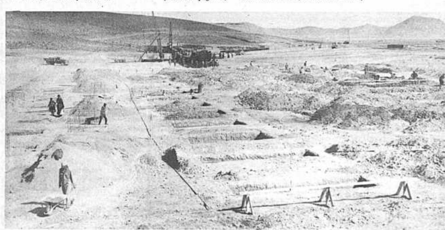
El duro suelo altiplánico cede ante el entusiasmo y el empuje de los bolivianos. Se trata de dar sólidos cimientos a la fundición de estaño. (Gentileza de ENAF)
