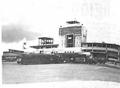
Vista del Edificio Terminal del Aeropuerto Internacional de El Alto, cuyos trabajos de remodelación se encuentran muy avanzados.
