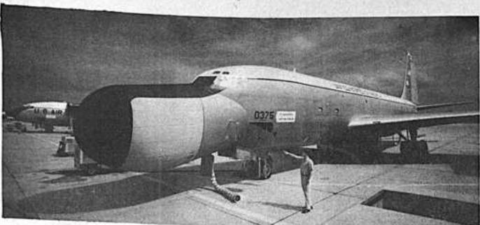
Uno de los ocho aviones a chorro, denominado A/R1A (avión de instrumentación de rango del Apolo), especialmente modificado e instrumentado para actuar como estación aérea de rastreo, necesario cuando se cambia de órbita o en el caso de un descenso fuera del lugar fijado y el Apolo se encuentre fuera del rango de las estaciones terrestres. (Foto USIS)
