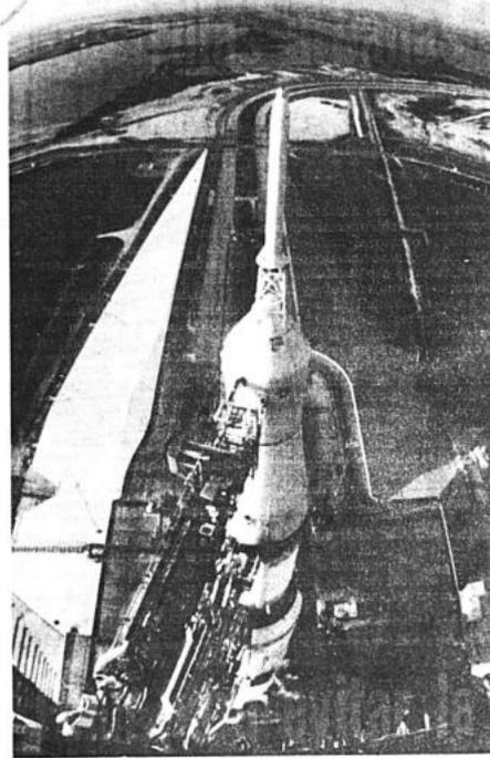
Fotografía de la torre umbilical de 300 pies, con el vehículo espacial Apolo - Saturno en su plataforma, durante la secuencia del conteo en descenso en el Complejo 39, en Cabo Kennedy, Florida. El vehículo de 363 pies de altura y con un peso de 6,208.94 libras, cuando está completamente cargado, llevará a los astronautas a la Luna a fines de 1969.
