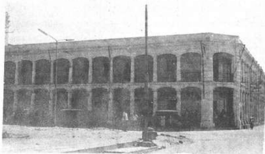
CASA DE LA CULTURA. Este es el inmueble por la Comuna y que es refaccionado con una inversión de $b. 1.367.000.
