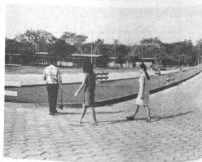
PAVIMENTACION VIAS INTERNAS. Jardín Botánico "Jamin Burela" se pavimentó varias veredas. Este trabajo del vivero municipal en el jardín ascendió a un monto de $b. 772.000.
