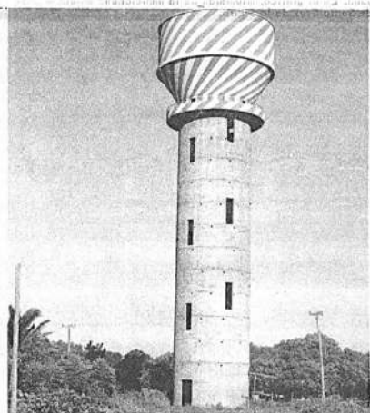
Con una capacidad de 1 millón de litros se levanta este moderno tanque elevado al sistema de agua potable de esta progresiva ciudad oriental. Constituye un símbolo vivo del adelanto que experimenta Santa Cruz en obras de carácter público.
