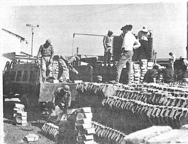
Efectivos del Batallón de Ingenieros "General Manuel Pando" están comprometidos en el adelanto del enlosamiento de la ciudad. En el gráfico, miembros de la mencionada unidad desorganizan losetas para nuevas arterias de Santa Cruz de la Sierra.
