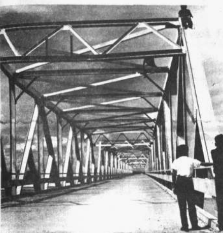
Puente sobre el río Piray, Santa Cruz.
