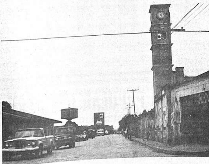
Hace algunas semanas, esta calzada ubicada frente al edificio del hospital general, presentaba aspecto pueblerino. Hoy, con su enlosamiento, ha cambiado radicalmente de fisonomía, desapareciendo de otra parte la calzada llena de arena y agua.
