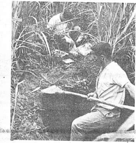
Para los estudios del potencial de suelos se tomaron miles de muestras de las capas superiores de los terrenos. En el gráfico de un pozo de perfil de suelos extraen muestras de tierra para ser analizadas en el laboratorio.
