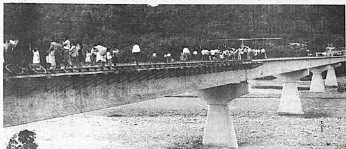
Este es el puente construido sobre el río Espíritu Santo inaugurado por el Presidente de la República, Gral. René Barrientos. Se trata de una obra de alta ingeniería, tiene una extensión de 500 metros y es parte del camino de penetración al Chapare, proyecto 1 y 4. Construyeron la ruta las empresas Jones e Ingenieros Asociados, con la asistencia económica de la Alianza para el Progreso.
