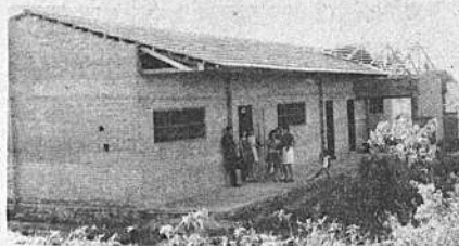
En la ciudad de Santa Cruz ha sido concluido un local escolar gracias al esfuerzo desplegado por los vecinos del barrio del cinematografista. El moderno y amplio edificio fue construido bajo la inquitada dirección de John Guy, voluntario del Cuerpo de Paz. En esta obra también cooperó la Alianza para el Progreso.
