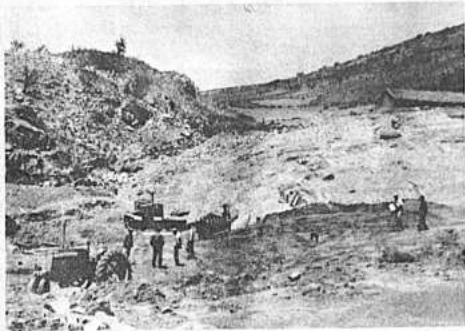
Esta es otra represa que se construye actualmente en Chapare. El movimiento de grandes cantidades de tierra ha hecho necesario la utilización de maquinarias especiales proporcionadas por Desarrollo de Comunidades. En las siguientes fases de construcción, los campesinos de esa región intervendrán en su trabajo.
