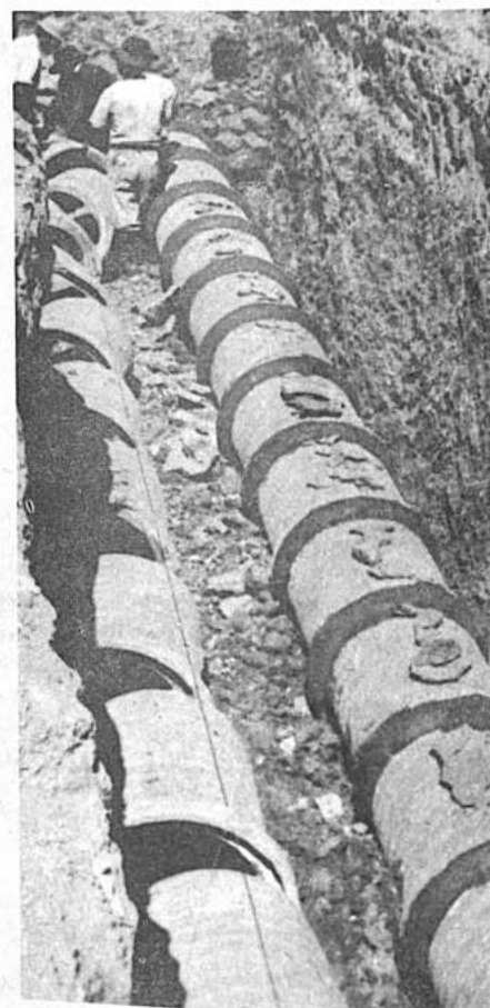
Ha sido renovado gran parte del sistema de desagües pluviales. El crecimiento de la población determina que los servicios públicos sean mejorados y aumentados en su capacidad.
