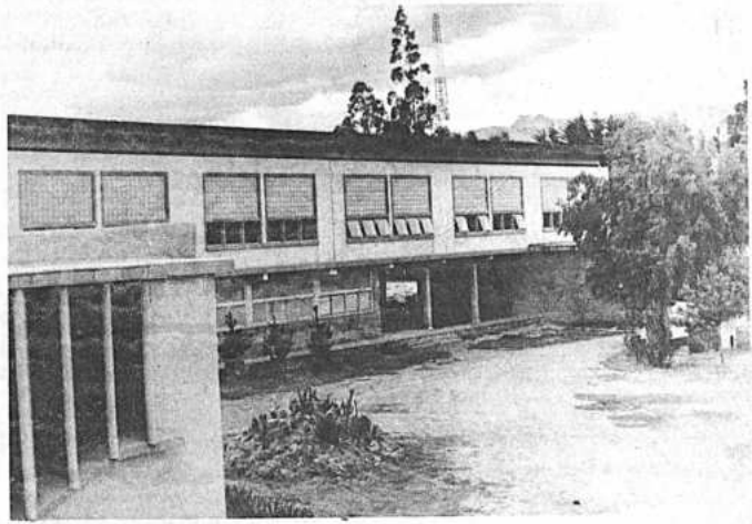
Este es el edificio moderno donde funciona la Facultad de Arquitectura. El terreno sobre el que está edificado tiene espacio suficiente para realizar nuevas ampliaciones.
