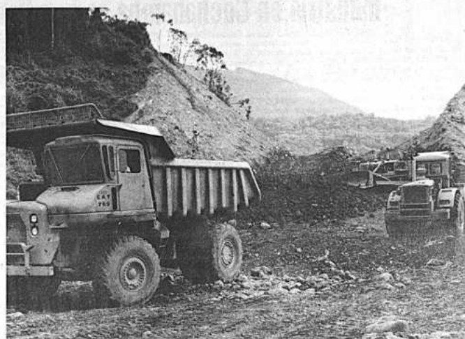
Maquinaria pesada de alto tonelaje facilita el movimiento de tierras en los diferentes sectores del nuevo tramo carretero 1 y 4. Arriba, camiones y tractores abren un talud en la zona de Paracti a 86 kilómetros de Cochabamba.
