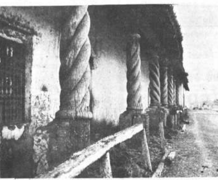
"El templo descansa sobre troncos de 'cuchi', muchas de ellas, recubiertas con ladrillos y estuco. La madera empleada en 1.753 está intacta pese a la acción del tiempo. En la construcción del templo se ensambló inmensas troncos de 'Cuchi' sin utilizarse clavo alguno. Arriba, parte de las troncos talladas que sostienen parte de una lateral del templo (Foto PRESENCIA).
