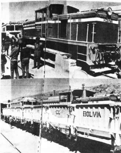
En las fotos se observa parte del nuevo material de fabricación que se exhibe desde ayer en la Estación Central. Este material fue adquirido con un crédito de diez millones de dólares destinados a la rehabilitación de los ferrocarriles.
