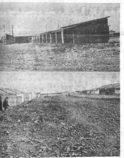
Esta es la escuela de la Ciudad Satélite. No dispone de un patio para el recreo de los alumnos y éstos tienen que acomodarse en aulas sin bancos. El edificio carece de vidrios en las ventanas, pues casi todos ellos han sido rotos o pedregados. Abajo, uno de los colles de la Ciudad Satélite que ha quedado sin empedrar. Los promotorios de tierra, como puede apreciarse, forman una hilera cuneta junto a una hilera de viviendas. La tierra, con el viento, le envuelve todo y penetra a los casas.
