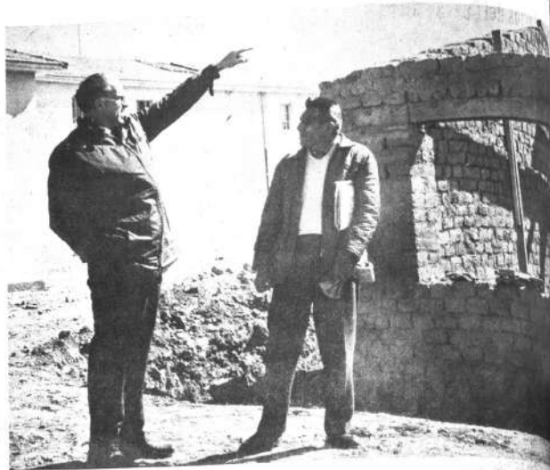
La Escuela Normal de Warizata está construyendo un comedor para 400 alumnos. Se está llevando a cabo la construcción con asistencia de USAID de 80,000 pesos bajo programa de la Alianza para el Progreso. El Dr. Orson Tew se ve aquí con el sub-director de la escuela, Florentino Wilca Calle, que fue uno de los alumnos fundadores de la escuela normal más grande del Altiplano.
